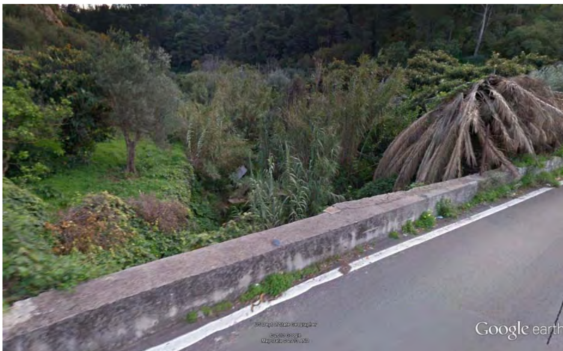
Altofonte (PA): 38.048091°, 13.311363° - attraversamento sulla SP5
