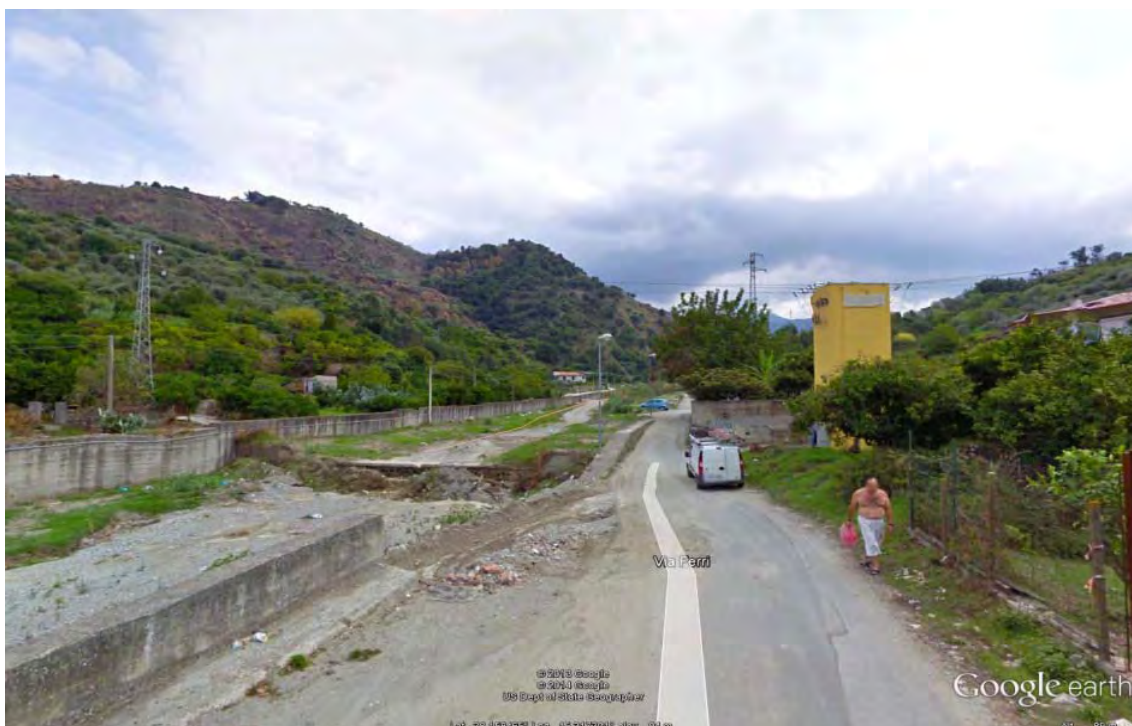
Gualtieri Sicaminò (ME): 38.158465°, 15.317301° - strada urbana (lato Santa Lucia del Mela) lungo la fiumara Gualtieri con interruzione del muro d'argine (sponda sinistra)
