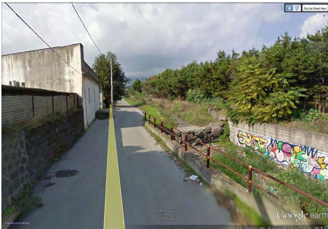
Aci Sant'Antonio (CT): 37.625347°, 15.110237°- la via Torrente Lavinaio sul Torrente Lavinaio
