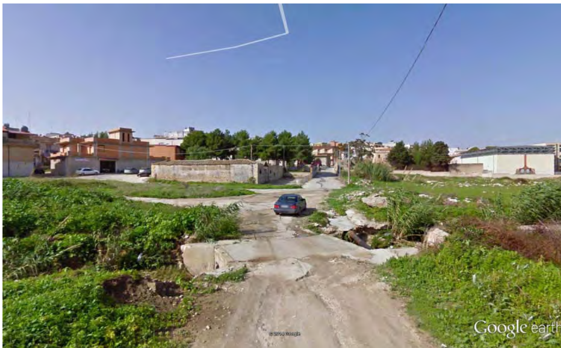
Pachino (SR): 36.716738°, 15.099662° - attraversamento a guado (di fatto) vicino il centro abitato
