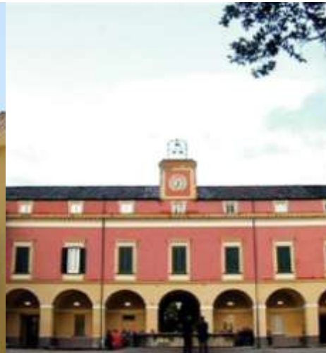
Complesso Real Polverificio Borbonico, Scafati
